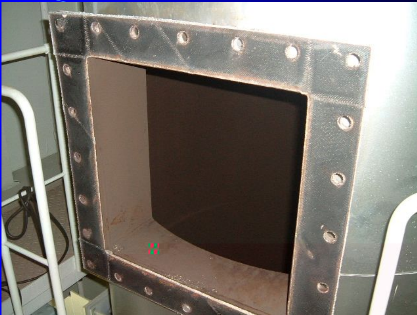
マンホール開口、煙路管内面を観る
